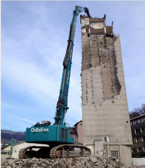
LMT SA, démolition d'un silo avec pince à béton de 43 m.
